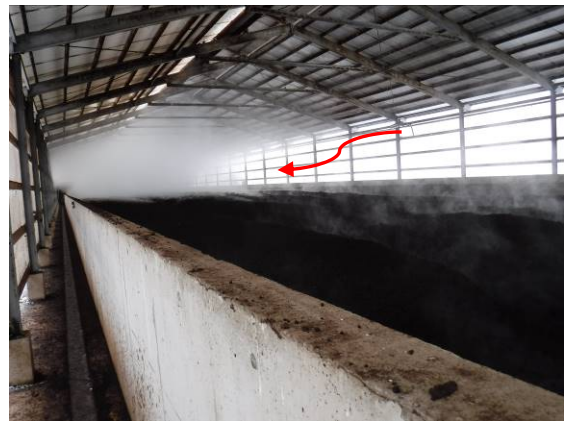
写真 42：北側の誘引ファンにより南側へ流れる状況
