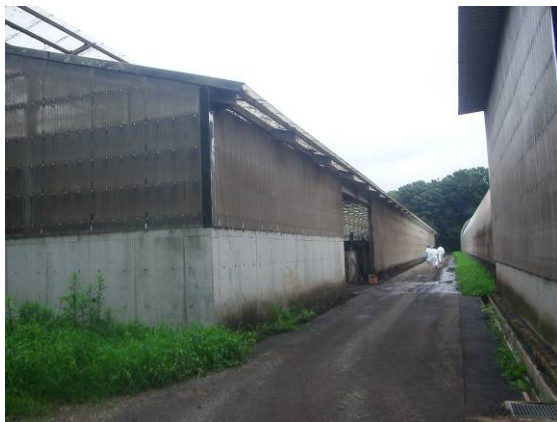
写真3：堆肥舎の搬出口側（南側側面）
