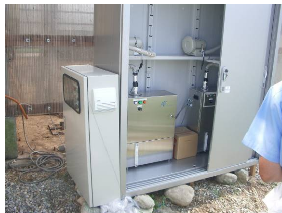
写真 10 : 気化脱臭装置本体の設置状況 (近景)
