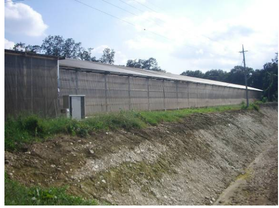
写真4：堆肥舎の北側側面
