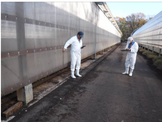
写真 23：堆肥舎開放面下部の流速測定状況（遠景）
