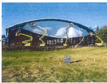
壁の膜張工事:囲われてくると暖かい現場に 11月16日
