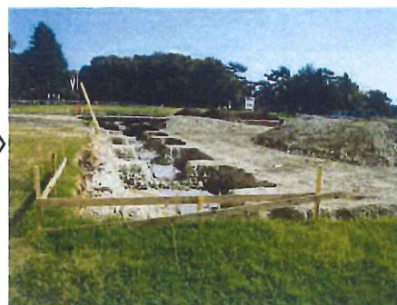
基礎工事に着手:地盤は砂利層でおおむね良好 9月25日
