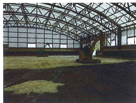
馬場床:ゴムマット+7号採石+TMgs'A砂 1月10日
