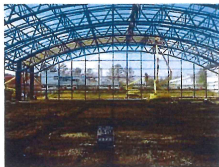
屋根の膜張工事:風の影響も少なく助かる 11月9日
