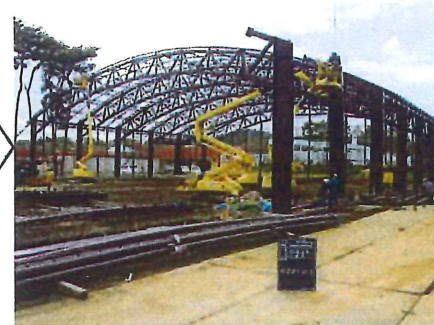
鉄骨建て方:囲われてみるとやはり大きい 10月31日
